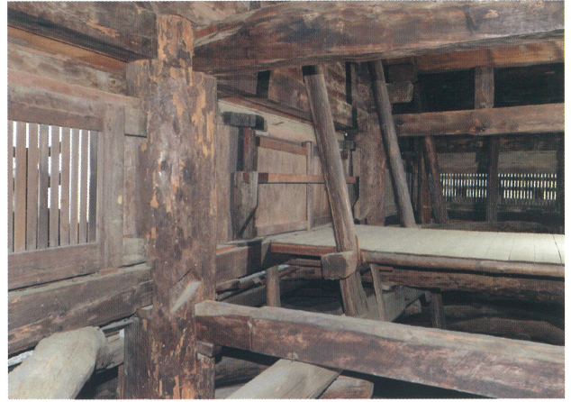
軸部の虫害（二重柱）
