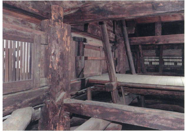
軸部の虫害（二重柱）
