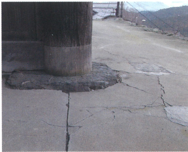
▲基壇の割れ・基礎の沈下
