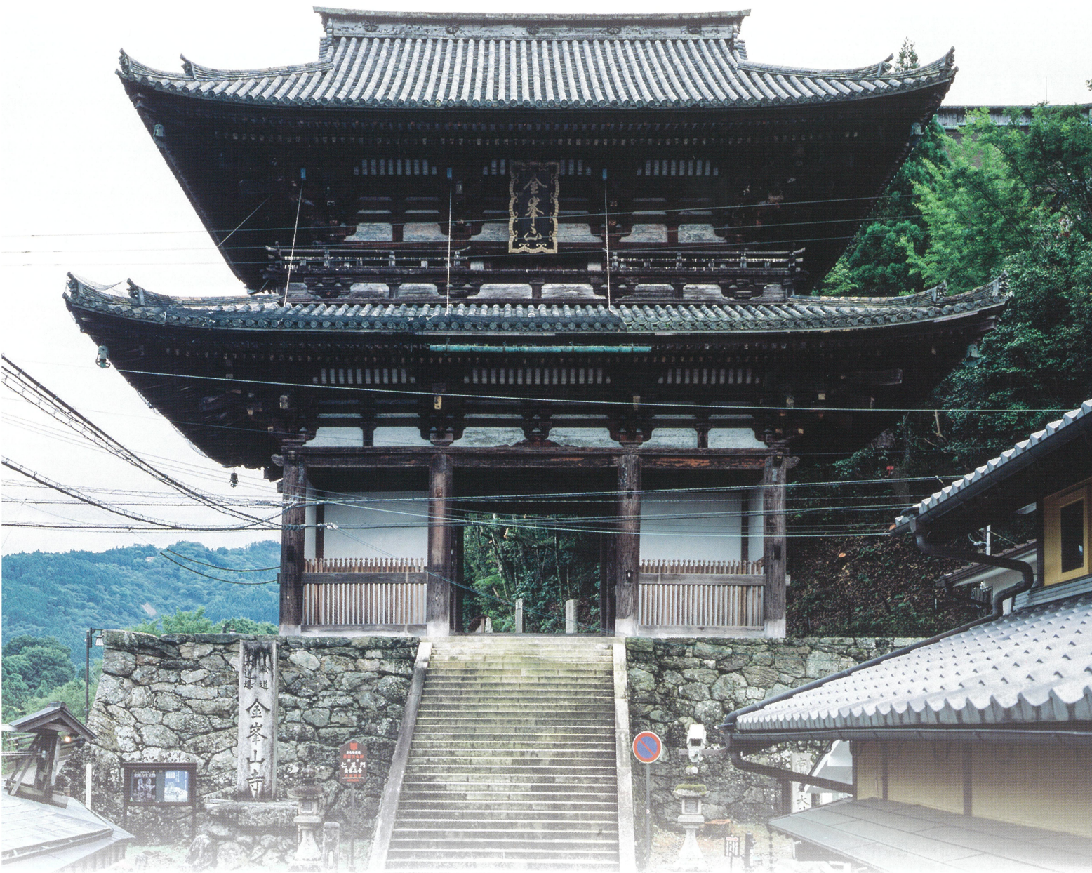
修理前二王門正面（※仁王像搬出後）
