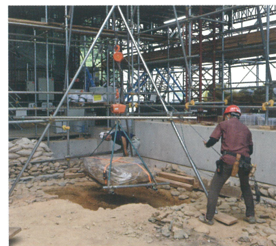
▲礎石の解体作業（北西隅）
